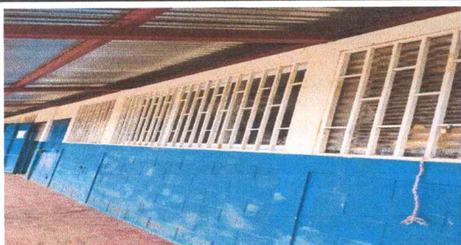
Foto 3: Mantenimiento a balcones de metal de ventanas (lijado, cepillado y aplicación de pintura anticorrosiva R15 de celco) a dos manos.
