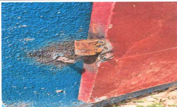
Foto 1: Mantenimiento a estructura (lijado, cambio de tubo, cepillado, sujeciones, aplicación de pintura anticorrosiva R15 de celco).
