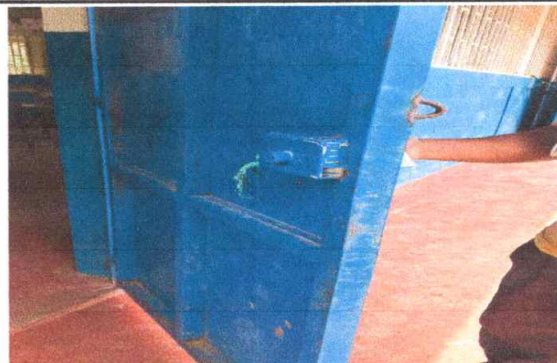
Foto 2: Cambio de chapa marca Yale de una puerta.
