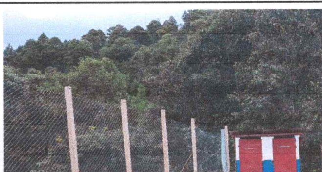
Foto 6: Reparación de tubo hg y malla galvanizada calibre 12 cuadro de 2 pulgadas.
