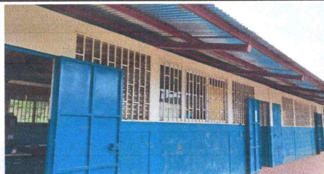
Foto 4: Pintura en muros Exteriores e interiores, con pintura de latex Excello de Sherwin Williams.
